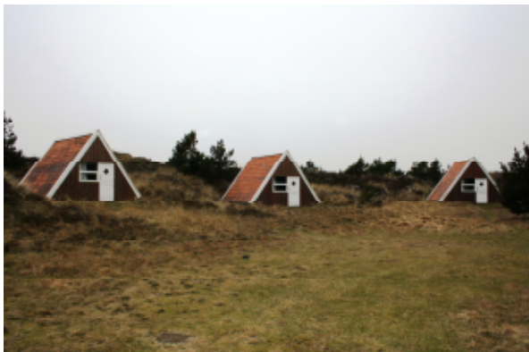
De eksisterende anneksbygninger ligger ved kliffoden.
